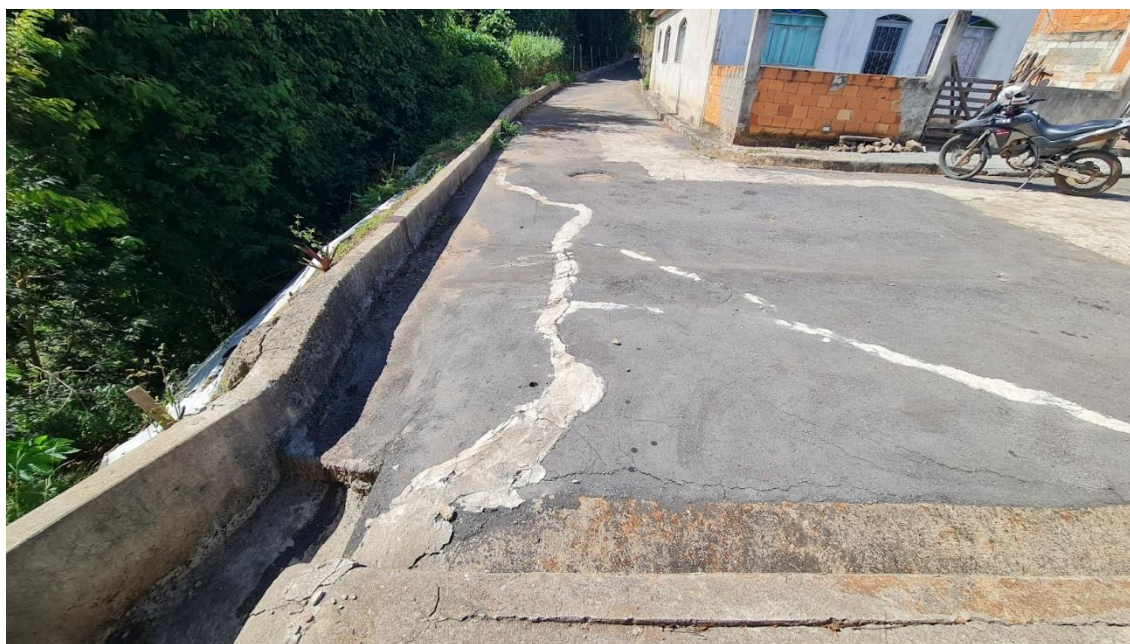
2.1.3 - Rua da Conquista (meio-fios com rachaduras, sinais de deterioração da camada asfáltica implantada, calçadas com trincas expressivas).
