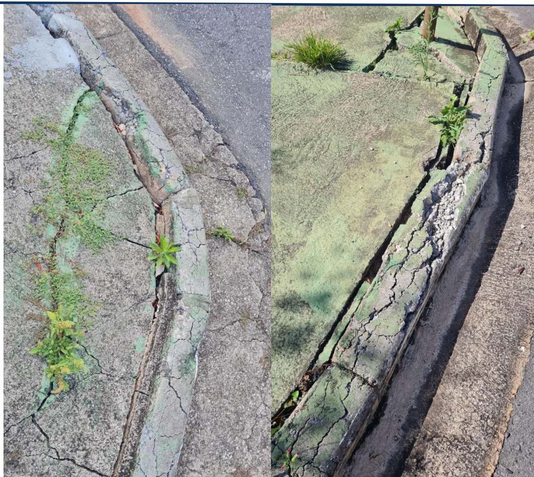
2.1.3 - Rua da Conquista (meio-fios com rachaduras, sinais de deterioração da camada asfáltica implantada, calçadas com trincas expressivas).
